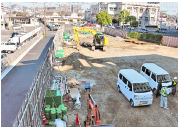
整地された建設予定地と西側の車道（10月27日）
