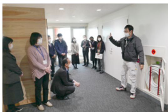
（有）亀屋防災担当者が消防設備を説明（7階）
