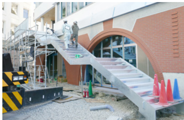
雁木をイメージした外階段（令和3年11月26日撮影） 現在は手すりも設置済みで、工事用の囲いで見えない
