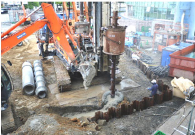
セメントミルクを投入しながらドリルで掘削（11月20日）
